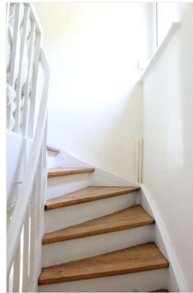
Treppe ins DG
