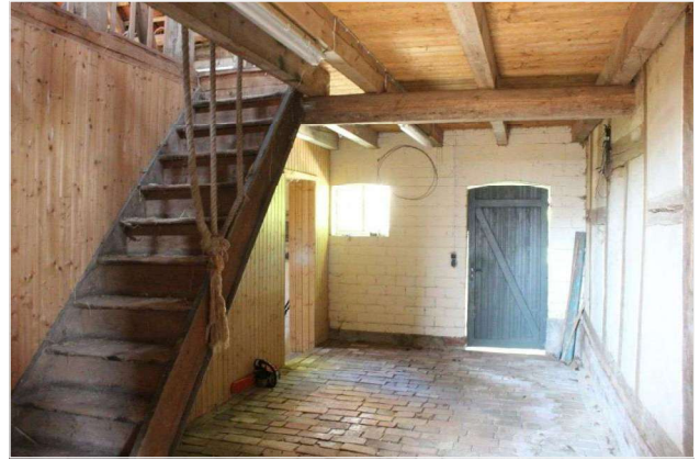
Scheune Treppe zum Heuboden
