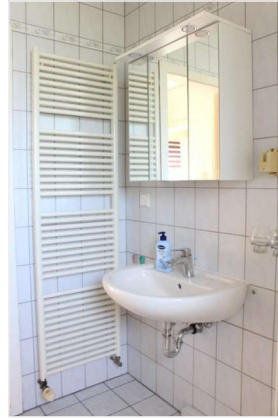
EG Bad Waschbecken
