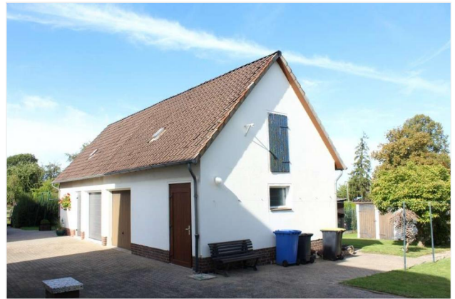
Nebengebäude mit Garage
